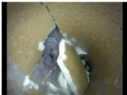
5) collapsed pipe
